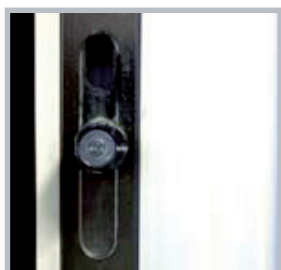
seřízení přitlaku na oknech - excentrický váleček
